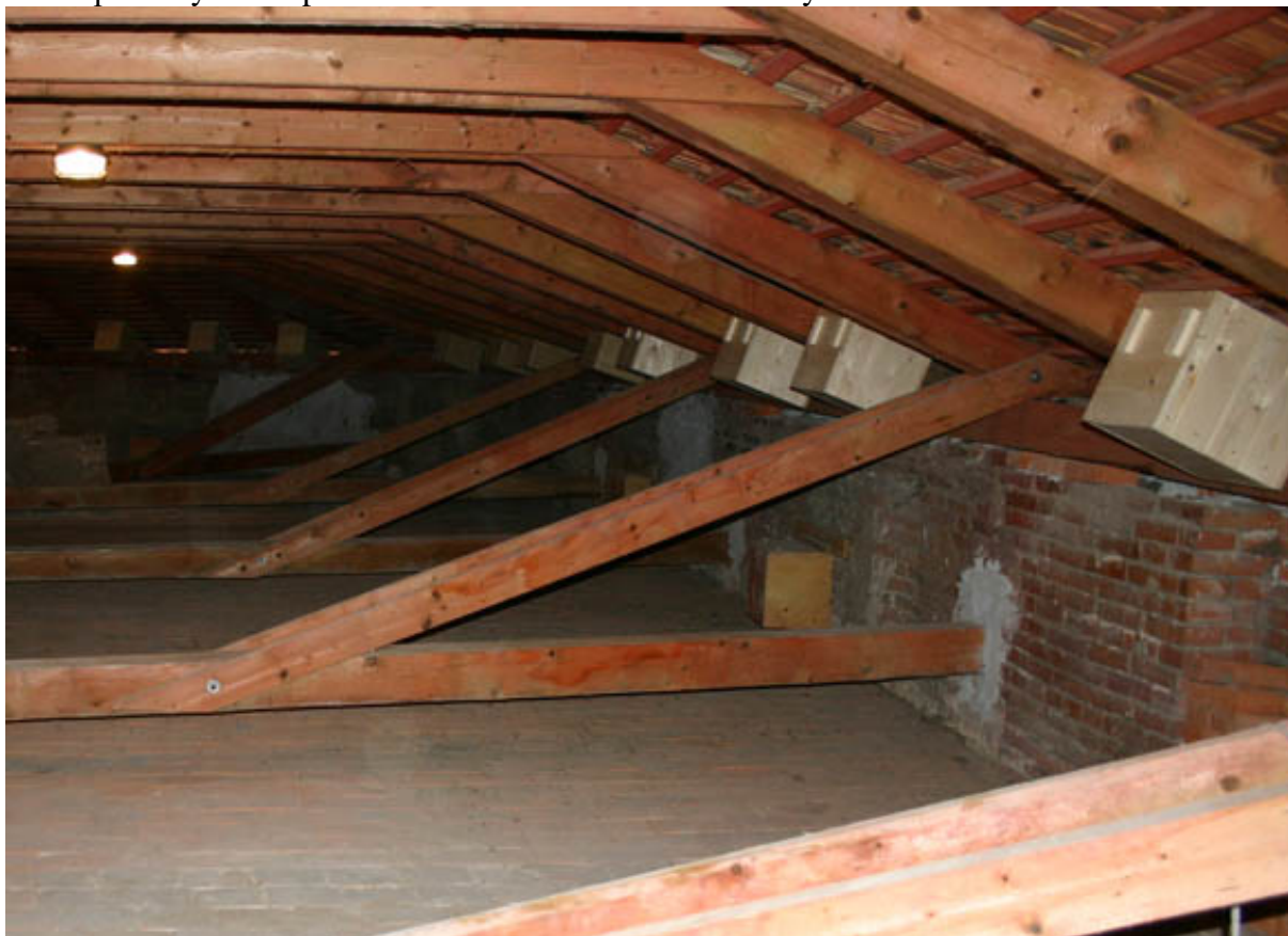
Půdní prostory hradu po celkové rekonstrukci s instalovanými budkami.
