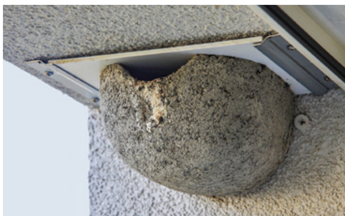
Dřevobetonové hnízdo umístěné na kovových lištách
