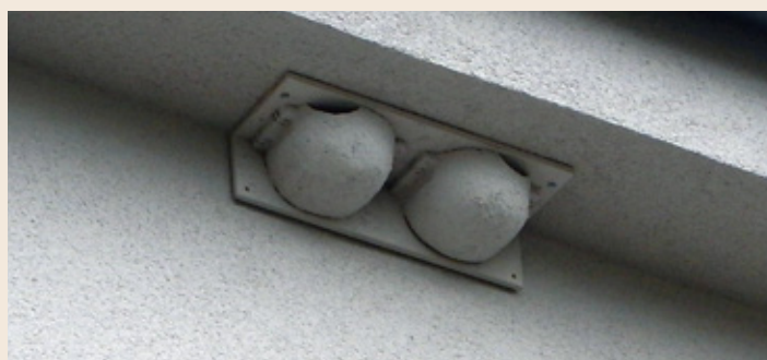
Detail instalovaných hnízd z dřevobetonové směsi
