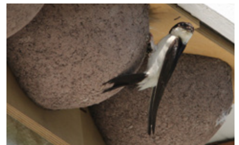
Dobrym řešením problémů se znečištěnou fasádou je instalace umělých hnízd, která jiříčky úspěšně obsazují
