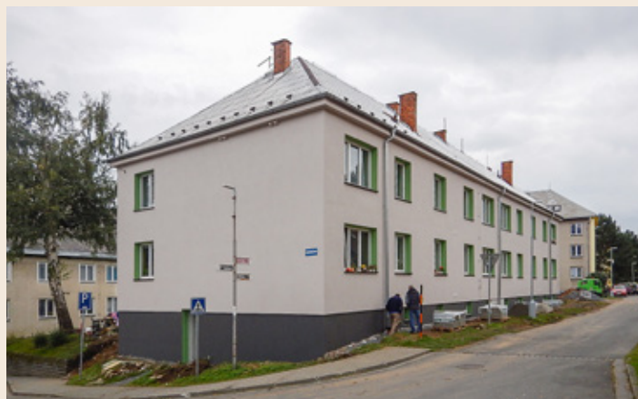
Celkový stav po rekonstrukci bytového domu ve Vrbně pod Pradědem. Umělá hnízda byla instalována na štitových stěnách pod římsou přesahu střechy
